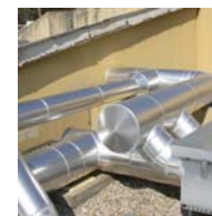
Contrôle de la perméabilité des réseaux de ventilation
